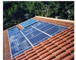
Panneaux solaires intégrés en toiture (source : Hutchinson FIT)
