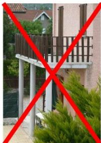
Les balcons sont construits en ossature sans maçonnerie (ni dalle ni pilier)
