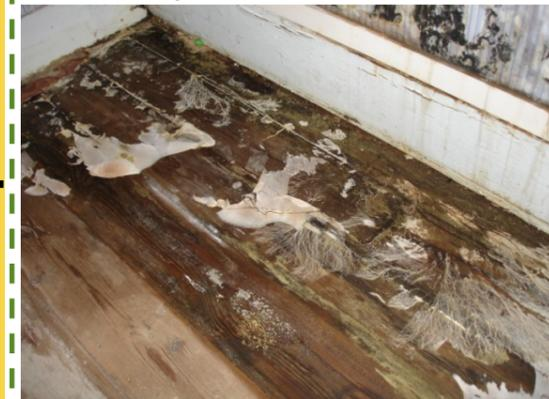
La présence de ce champignon lignivore dans les constructions n'est pas intrinsèque à un type constructif. Sa découverte est souvent faite suite à des travaux d'emménagement, comme la dépose d'éléments.
